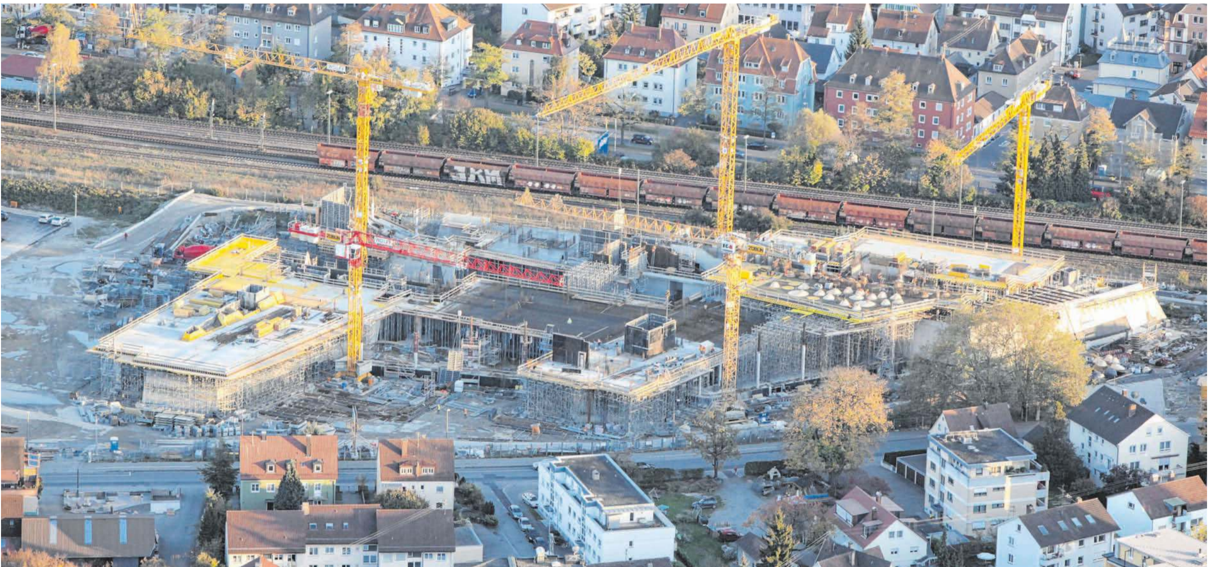
Mehr als drei Jahre lang war die Baustelle des ZF-Forums die mit Abstand größte Baustelle in Friedrichshafen.
