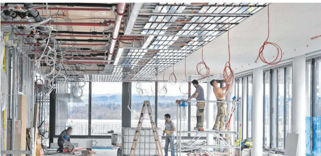
410 Kilometer Starkstromkabel und rund 240 Kilometer Schwachstromkabel werden innerhalb des ZF Forums verlegt. Die Bruttogeschossfläche beträgt rund 30 000 Quadratmeter.
