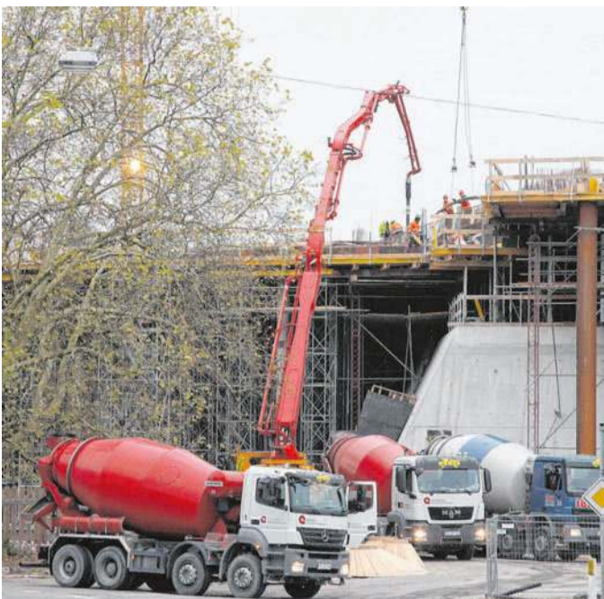
Rund 26 000 Kubikmeter Beton werden beim ZF Forum verbaut.
