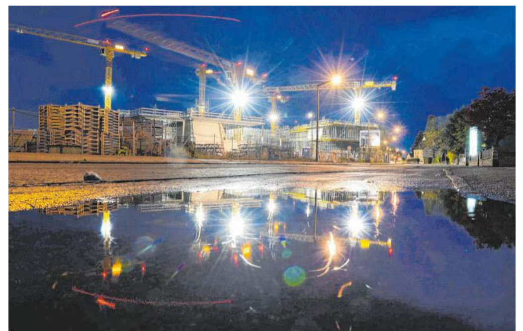
Etwas mehr als drei Jahre lang ist die Baustelle des ZF Forums die größte Baustelle der Stadt. Das Gebäude entsteht auf einem 20 000 Quadratmeter großen Grundstück. FOTOS: ZF
