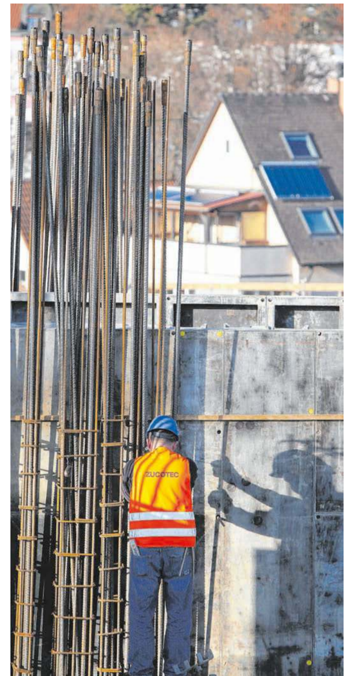
Rund 7000 Tonnen Stahl werden verbaut und 321 Stahlbetonpfähle mit einer Länge zwischen 25 und 32 Metern gesetzt.
