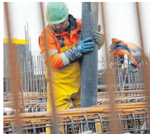
Während des Rohbaus ist die Betonpumpe unentbehrliches Hilfsmittel für die Arbeiter.
